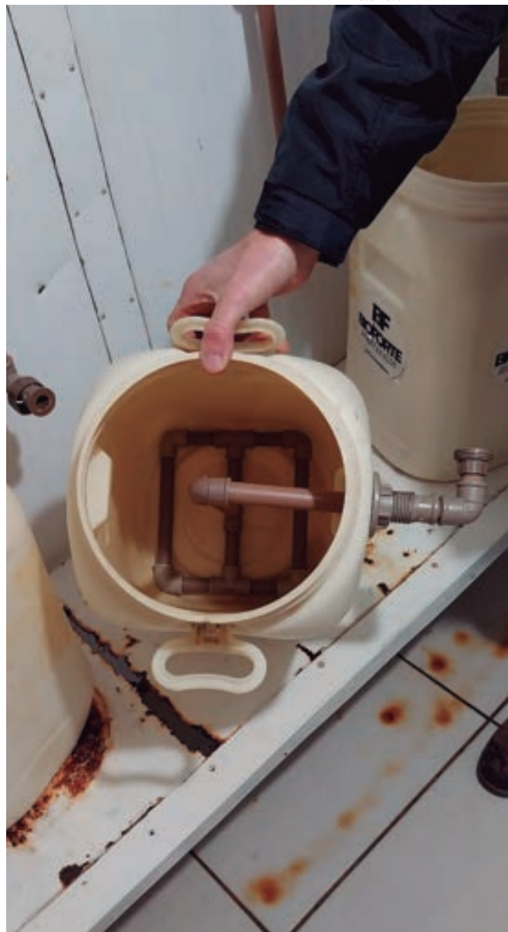
Biorreator com aerador no fundo. Grupo Mãos na Terra 5 , 2025
